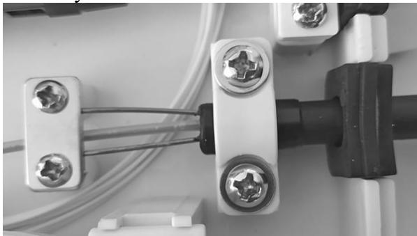
3.5 Протягніть кабель через гумовий ущільнювач і зробіть кілька витків ізострічка на кінці кабелю. Зафіксуйте кабель в кріпленні для кабелю, потім зафіксуйте силовий елемент в кріпленні для силового елемента. Модуль повинен розташовуватися під кріпленням для силового елемента.
