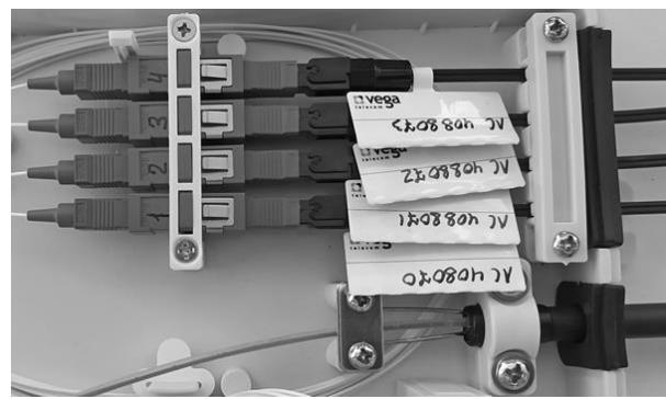
4.9 Під'єднати кабель до адаптера і пробіркиуйте його. Маркером напишіть номер сполучної лінії, адресу установки та номер наряду. Зафіксуйте абонентський кабель кріпленням.
