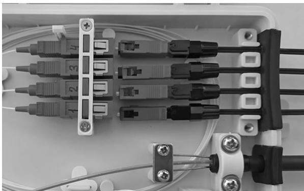
4.6 Протягніть абонентський кабель через гумовий ущільнювач у бокс, та змонтуйте зварний з'єднувач.
