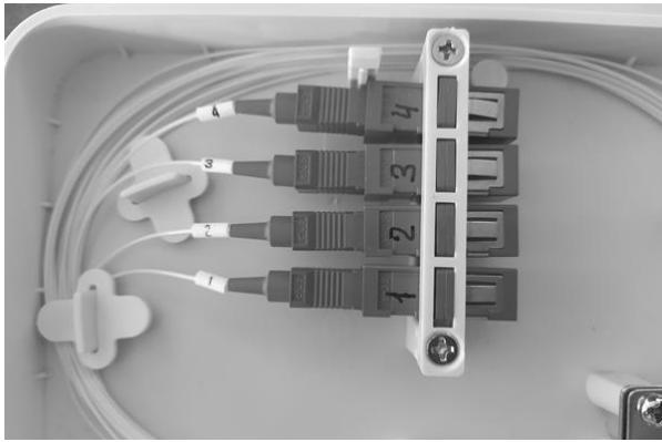
3.3 Виведіть кінці дільника з роз'ємами зі сплайс-касети вниз, і під'єднайте до адаптерів з відповідними номерами. Викладіть запас оптичних волокон на дні оптичного боксу.
