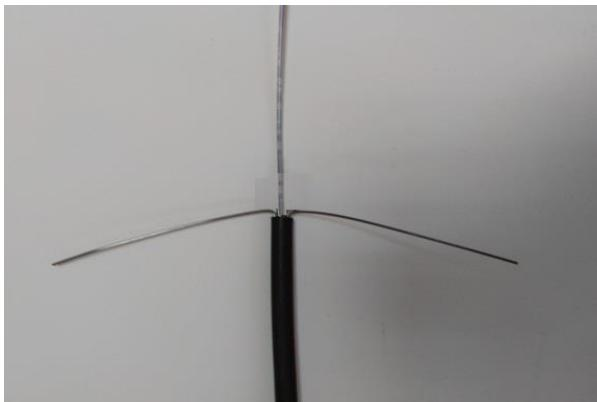
3.4 Видаліть оболонку кабелю на довжині приблизно 1 м. Для запобігання обривів волокна не обрізайте оптичні модулі. Відріжте силовий елемент, залишивши максимум 5 см.
